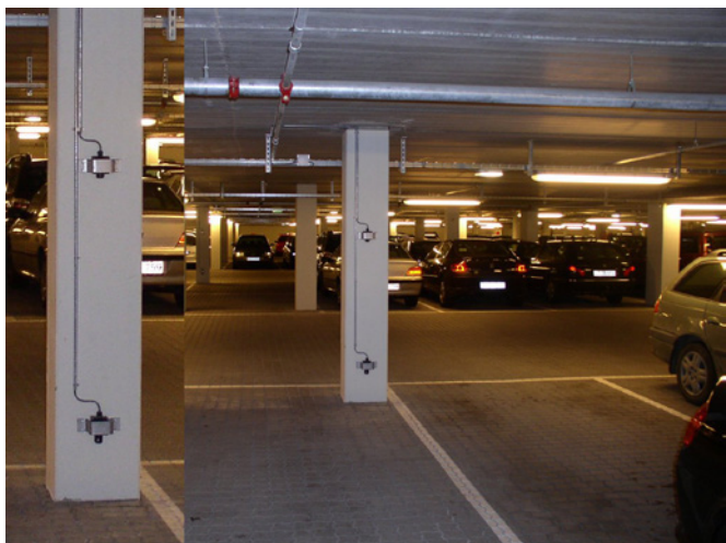
Eksempel på installation med GP-SB detektorer i parkeringskælder
